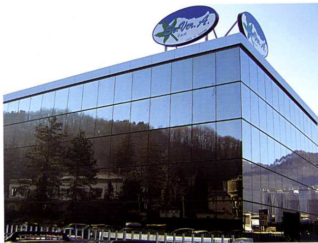
Sede Ecocentro in Castelnuovo di Garfagnana Via Pio La Torre, 2/A
