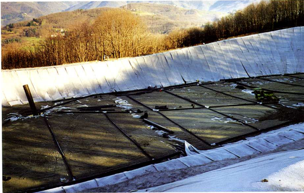
La discarica situata in località Selve Castellane nel comune di Molazzana. Lavori di realizzazione.
