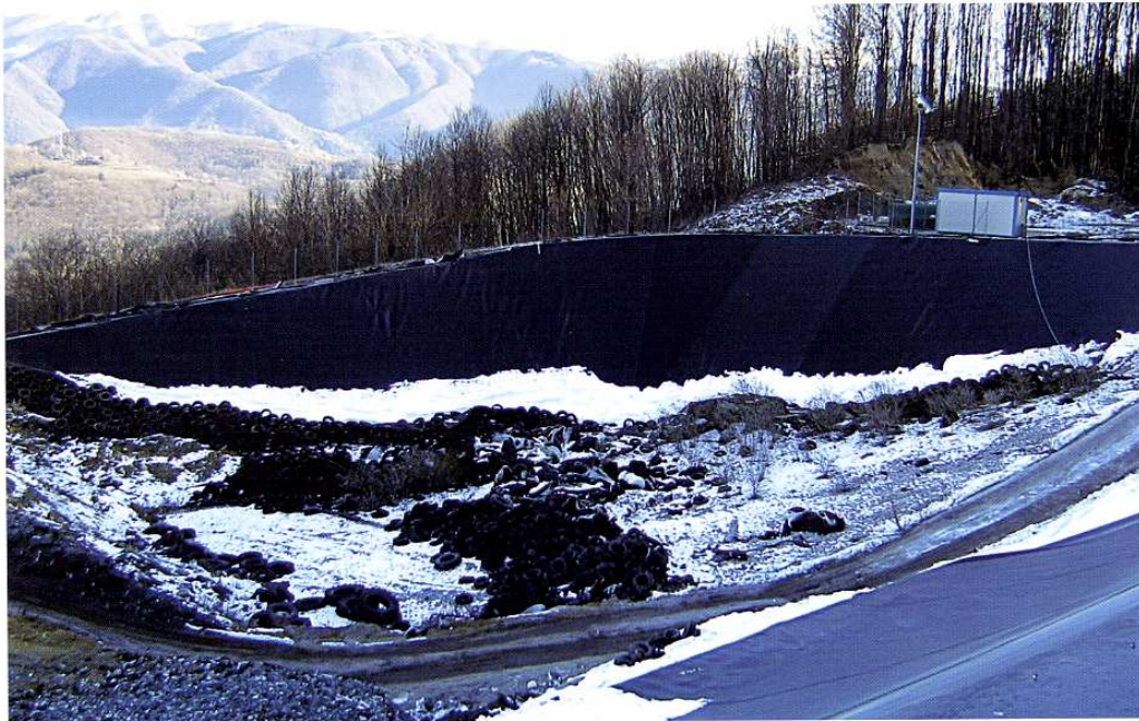
La discarica di Selve Castellane accoglie le ceneri di combustione provenienti dal termovalorizzatore di Castelnuovo, della Icl di Fornaci e della Tev di Falascaia.
