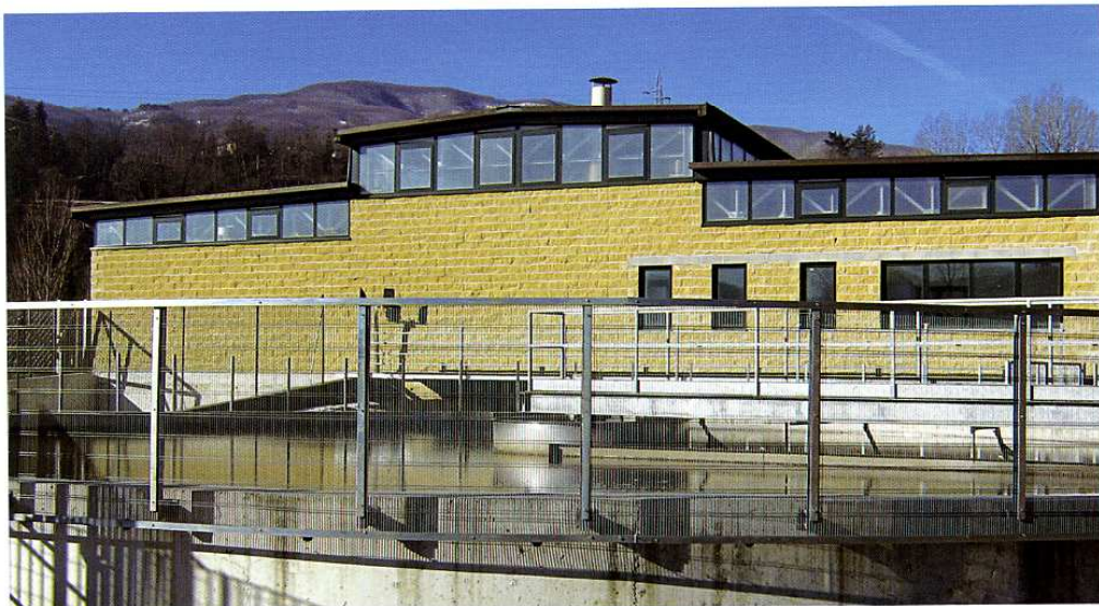
Depuratore di Castelnuovo in località La Murella
