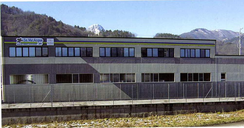
Lo Stabilimento di Se.Ver.Acque s.r.l.
